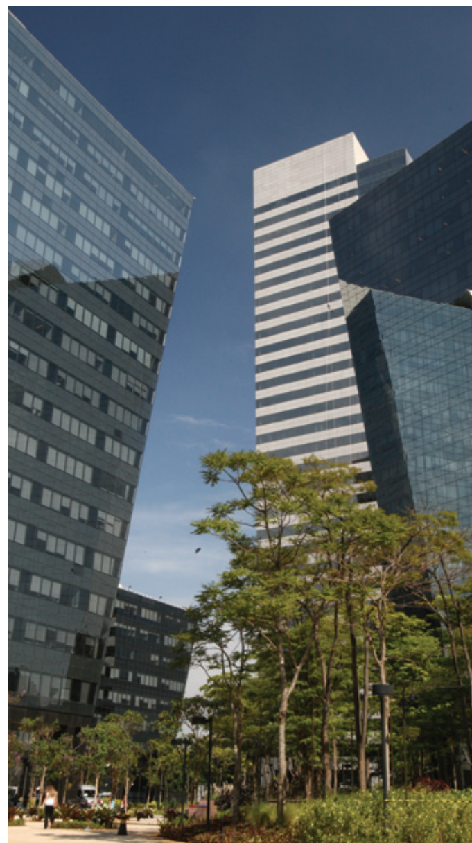
Edifício Rochavérá, em São Paulo, conta com revestimentos a pó para proteger a fachada
