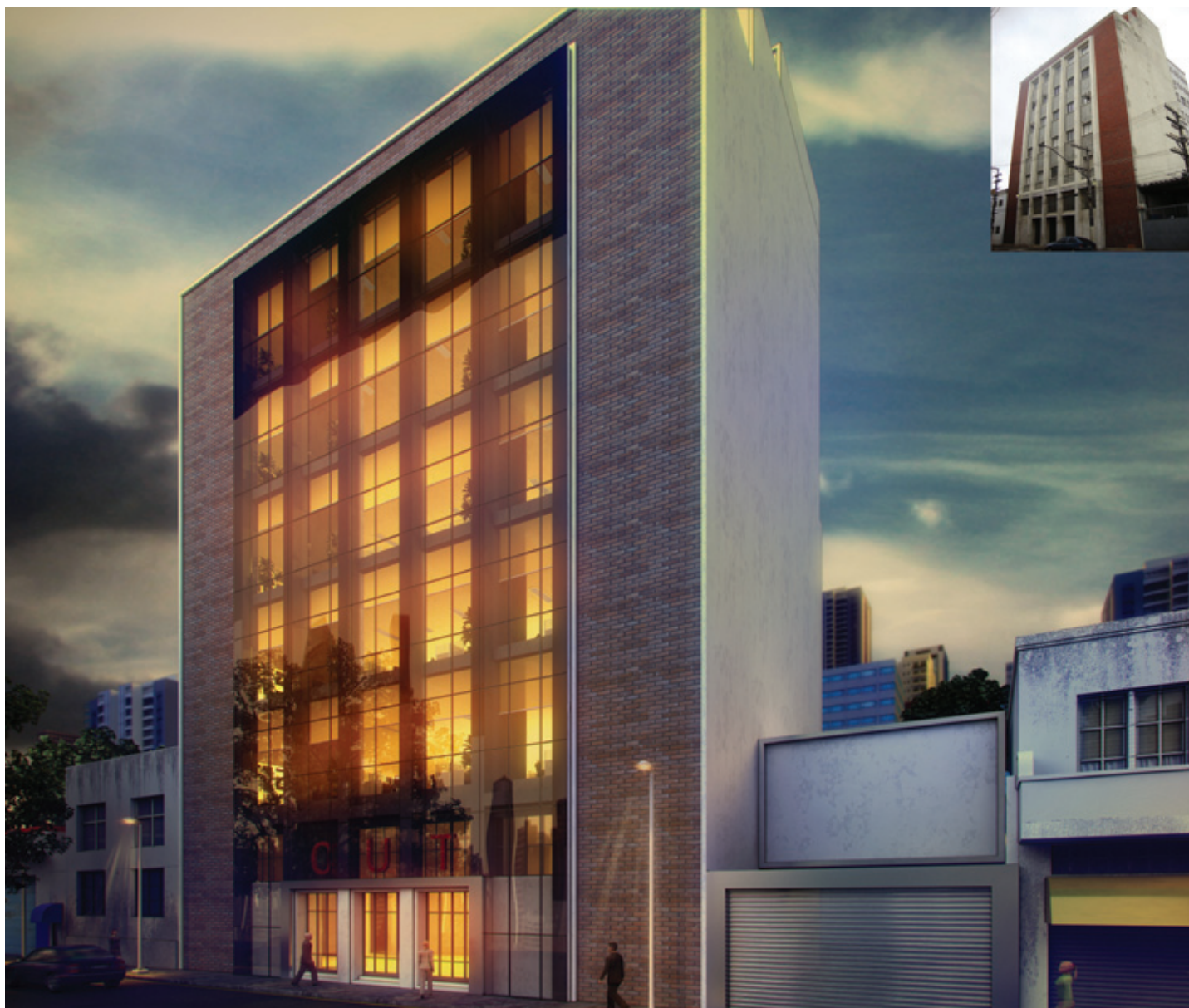
Projeto, Construção, Reforma e Retrofit de Edifícios Comerciais
