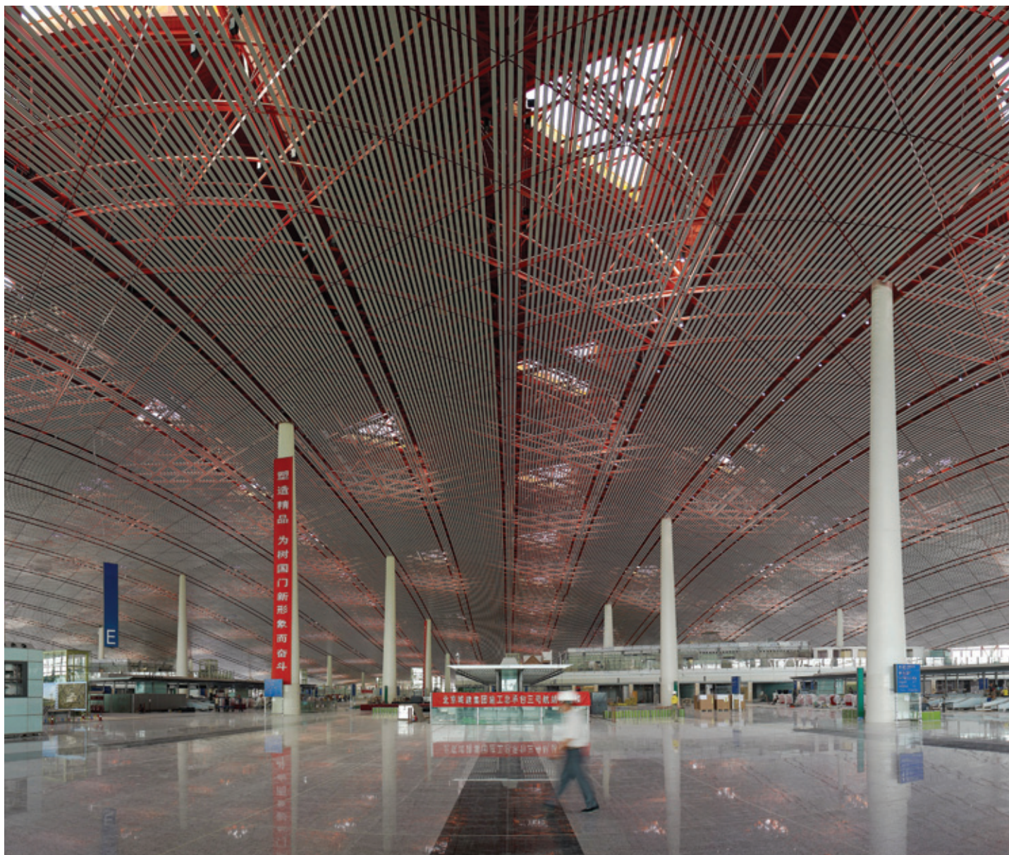
Revestimentos especiais protegem estruturas metálicas no Aeroporto Internacional de Beijing, na China
