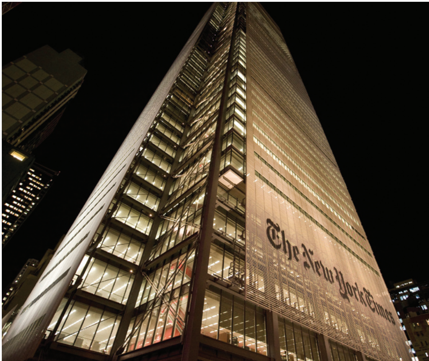
O prédio do The New York Times recebeu revestimentos para proteção passiva contra fogo
