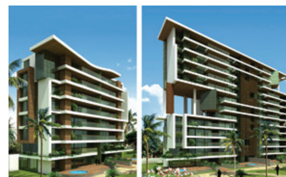
Residenciais Acqua Marine Beira Parque · Rangel Moreira Arquiteto
