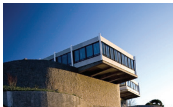
Empreendimentos Multiuso Showroom DellAnno · Sousa Guerra e Pedro Simch Arquitetura
