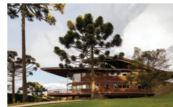
Unifamiliar · Predial Campos do Jordão Residência · Mareines + Patalano Arquitetura
