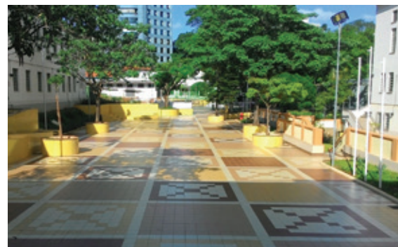
Retrofit · Predial Colégio Sagrado Coração de Maria · Arqsol Arquitetura
