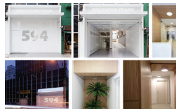
Retrofit · Predial Edifício Itaim - Desiree Felix Arquitetura
