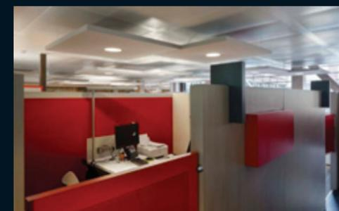
Divisórias suspensas, fixadas com cabos de aço ou placas fixadas no chão garantem privacidade e conforto acústico
