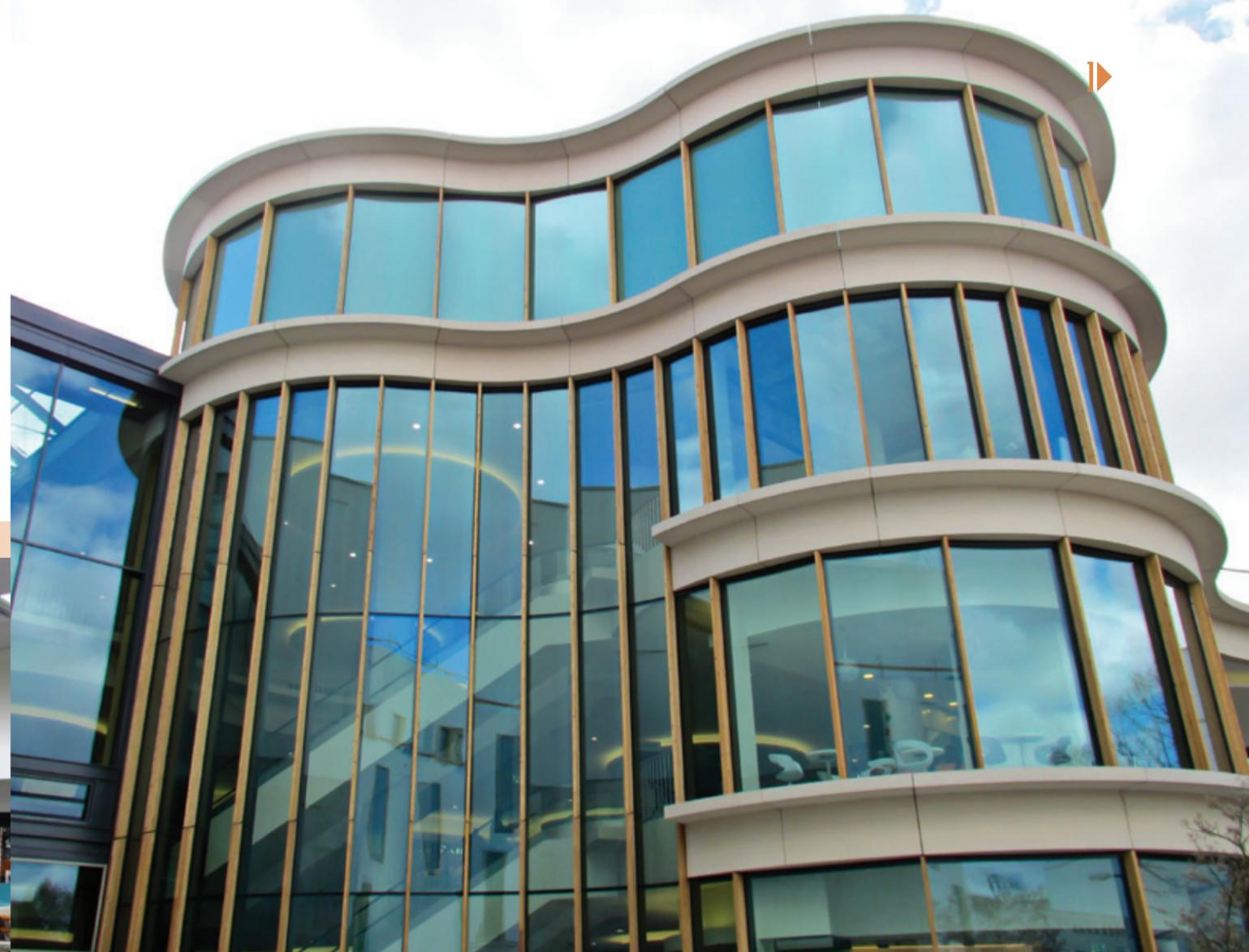
Nas fachadas, a colocação de vidros espelhados mantém a temperatura interna durante sol forte, devendo ser previstos mecanismos que permitam a abertura das janelas em determinadas horas do dia, para aproveitar a ventilação natural.
