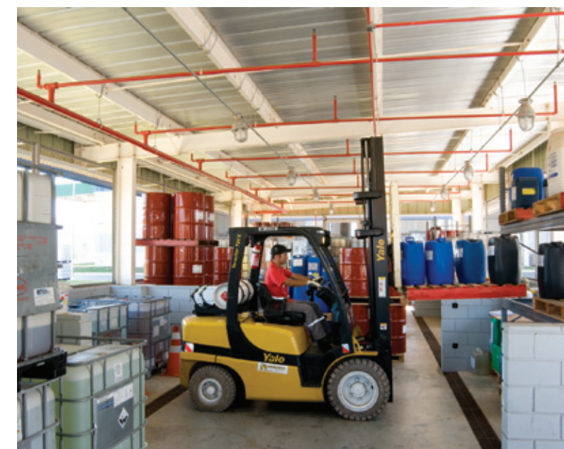
Piso industrial com fibras de aço garantem resistência e durabilidade
