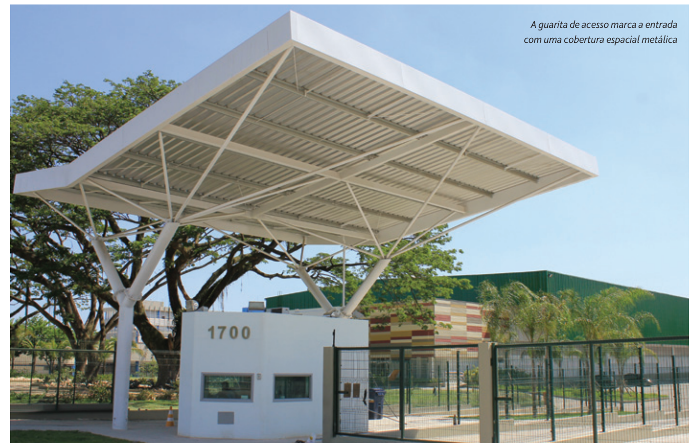
Os pedestres são direcionados por calçadas pela Praça de Convívio até o Edifício de Apoio
