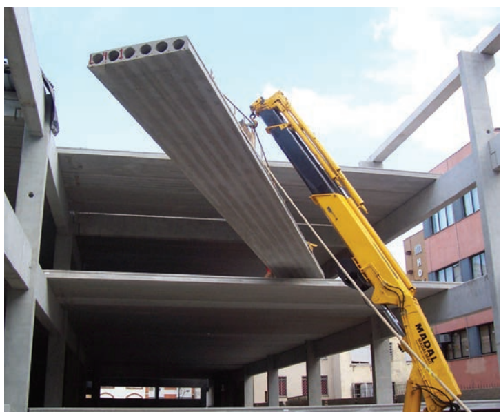
Concreto pré-fabricado apresenta ótima qualidade de fabricação e velocidade para execução da obra
