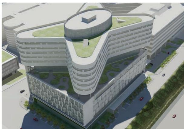
*Rush University Medical Center Hospital Tower possui 5 telhados verdes, iluminação e ventilação autosuficiente, mais de 90% do entulho foi reciclado, além de significativo acúmulo de água proveniente do sistema de ventilação.*
