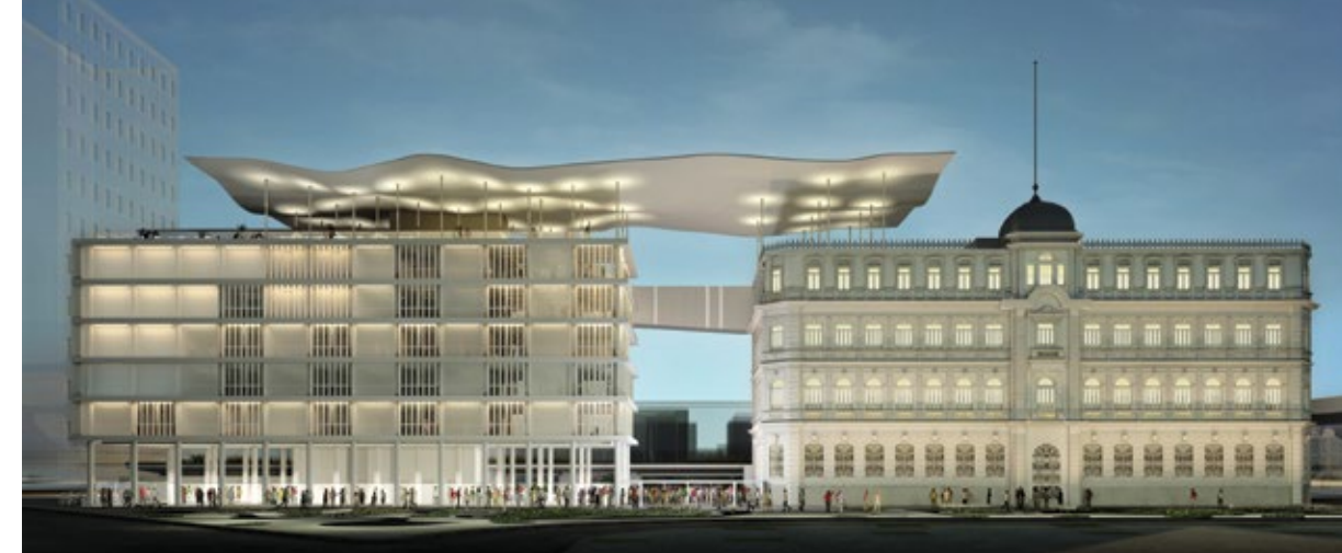
MAR, o Museu de Arte do Rio, projetado por Bernardes e Jacobsen unindo um edifício eclético e um modernista através de uma cobertura contemporânea
